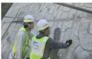
〈옹벽 시설 점검사진〉
