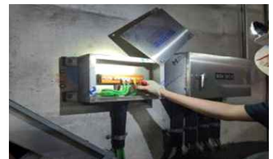
<터널 내 접지단자함 점검>
