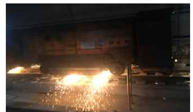
<레일 연마 작업>
