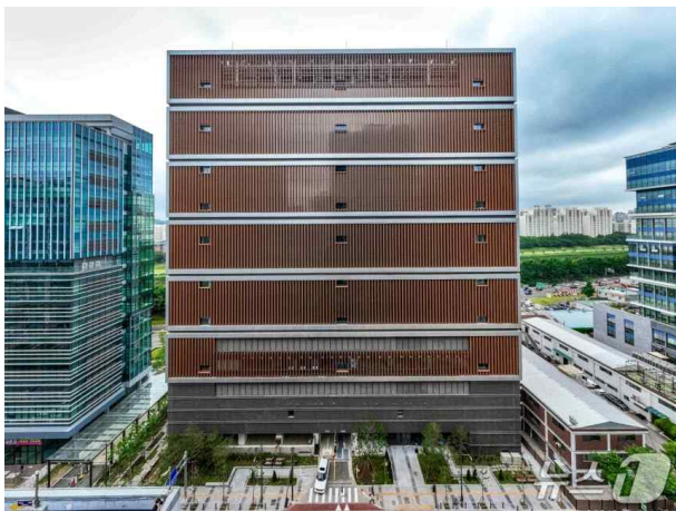
[금천구 가산동 데이터센터 전경] 출처: 뉴스1(2025.11.6.)기사 9)
