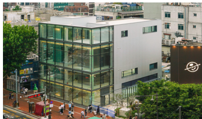
리모델링 공사 후
