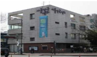
리모델링 공사 전
