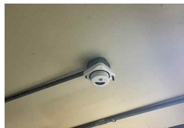
〈점포 내부 설치〉
