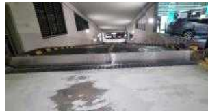
〈주차장 차수판 설치〉
