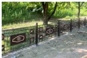
[북성벽 디자인펜스 설치]
