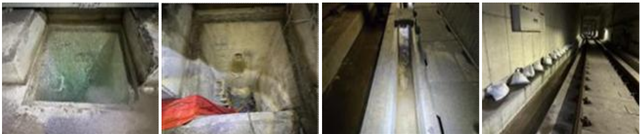
< 워터젯 작업(전, 후) >
