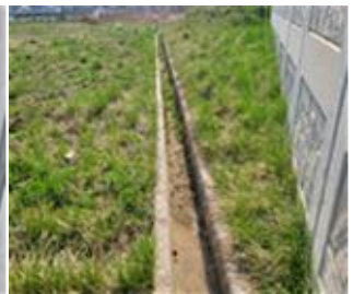
< 사면입구 개방형 배수로 >
