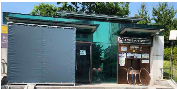
<임시가림막 설치 현황(파손노출)>
