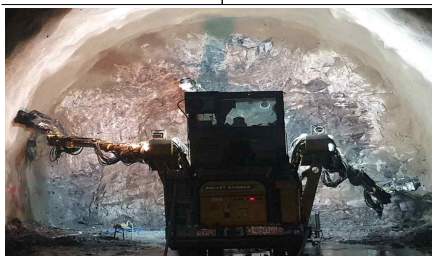
본선 터널 굴착(1공구)
