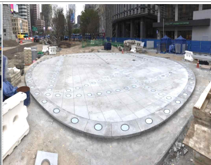
한글분수(수경시설) 설치 완료
