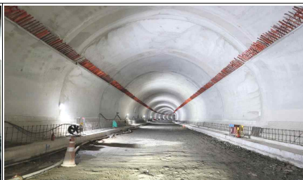
본선 터널 라이닝 시공(2공구)
