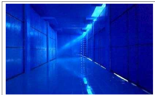
< 시공 후 - 2정수지 내부 >
