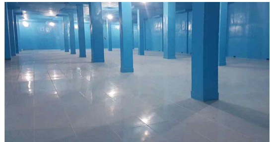
〈 공사 후 광암 정수지 〉
