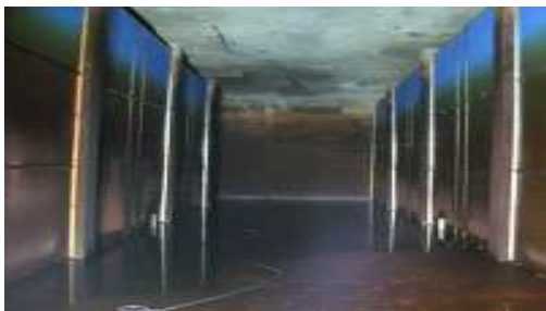
〈 공사 전 뚝도 정수지 〉
