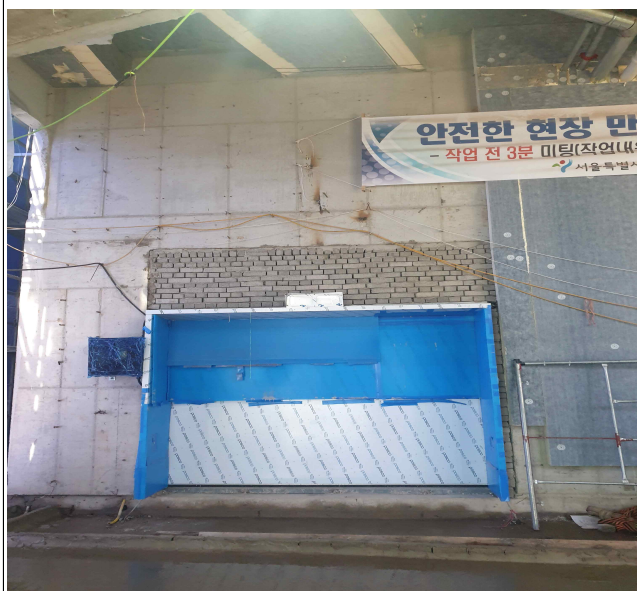
지하 기계식 주차장 출입구
