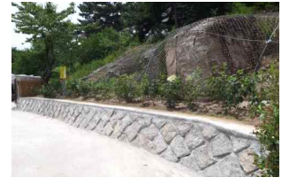
< 낙석망 등 설치 >
