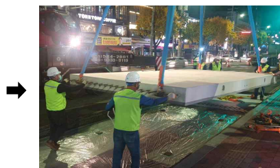
〈현장 조립 시공〉
