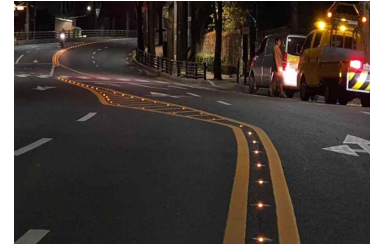
〈도로표지병 보완 시공〉
