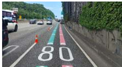
〈노면표시(노면색갈유도선) 설치〉
