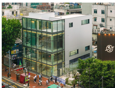
리모델링 공사 후
