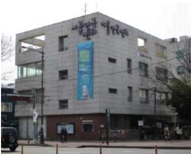
리모델링 공사 전
