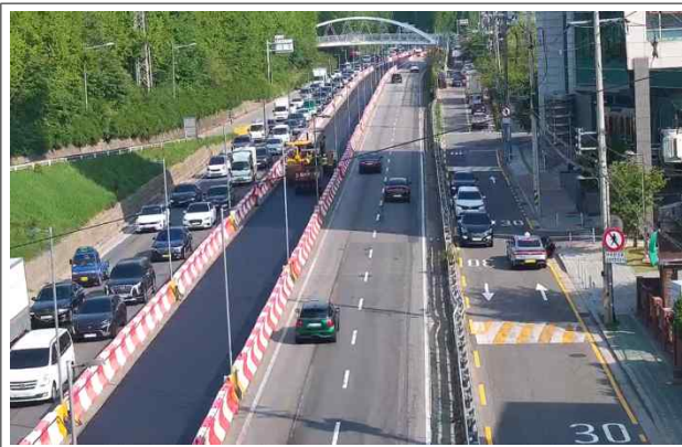
〈금천구 중분대 구간 포장 및 교통전환〉
