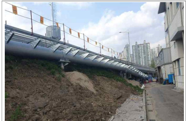
〈양평유수지 연결보행교 시공〉
