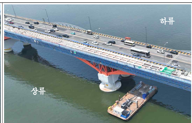
바닥판 철거(상류측 480m 완료)
