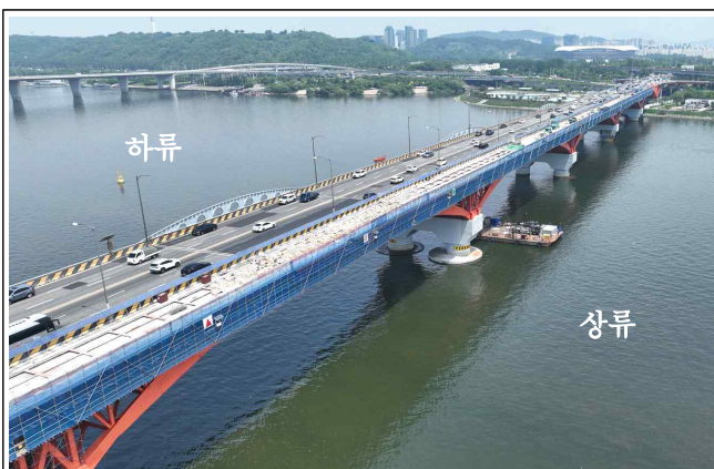
공중비계 설치(상류측 완료, 하류측 40m 완료)
