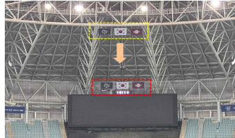
〈게양기 개선 설치〉
