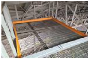
〈켓워크 발끝막이판 설치〉
