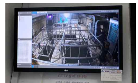
〈정화조 CCTV 설치〉
