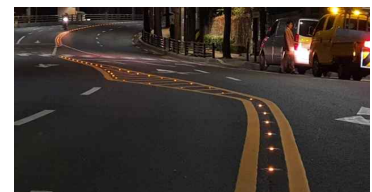
<도로표지병 병행 설치>
