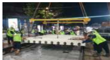
<현장 조립 시공 >
