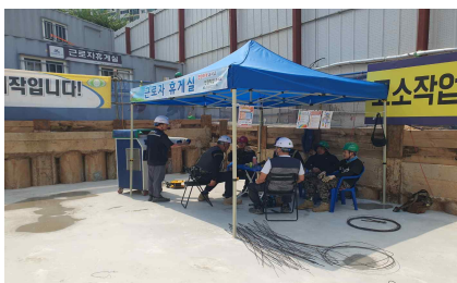
폭염대비 건설 현장 안전점검
