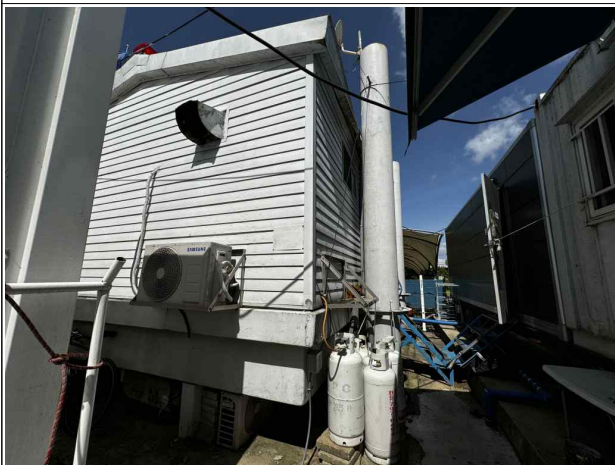
이동식 건물(컨테이너)로 분리 및 장비 외부 비치에 따른 사고발생 위험 증가
