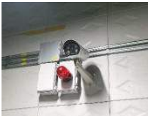
〈밀폐공간 CCTV 설치〉
