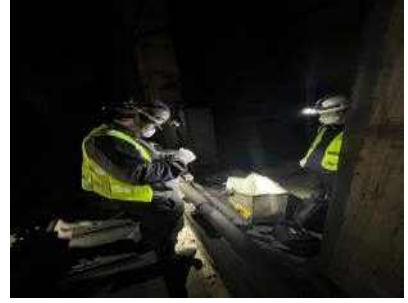
< 터널 내 연결송수관 조사 >
