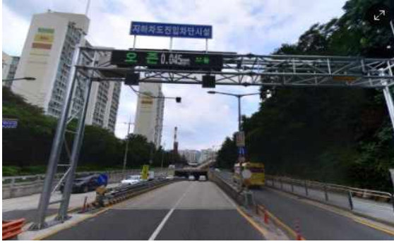
지하차도의 콘크리트 바닥
