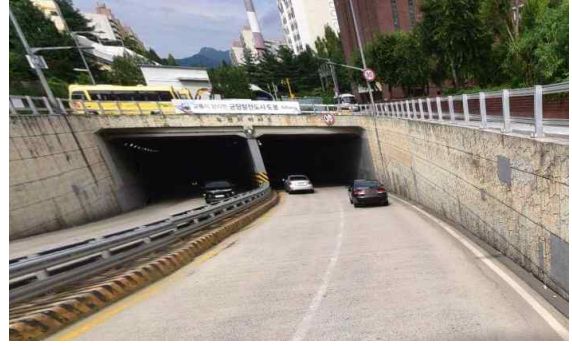
지하차도 내 횡방향 그루빙 현황
