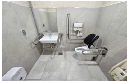
장애인 화장실 (타일교체, 손잡이설치, 세면대높이수정)
