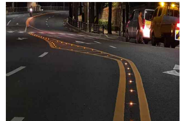
< 도로표지병 병행 설치 >
