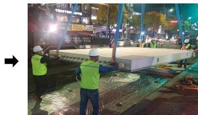
<현장 조립 시공 >
