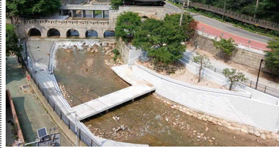
<보행램프 및 보행교 설치>
