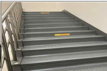
내부계단 한쪽 면 난간 설치
