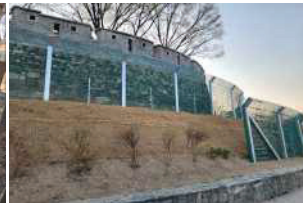
[낙산 낙석방지책 설치]
