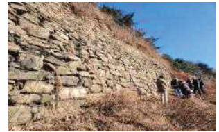
[위험구간 공사] ▲ 남산
