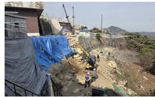
[붕괴구간 공사] ▲ 인왕곡성
