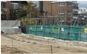
[위험구간 공사] ▲ 혜화동
