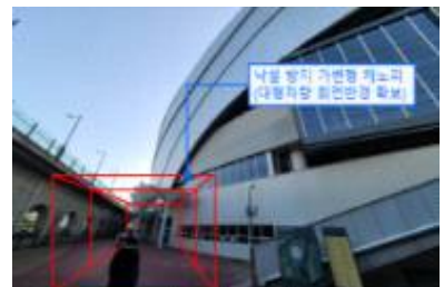
〈낙설방지 캐노피 설치〉
