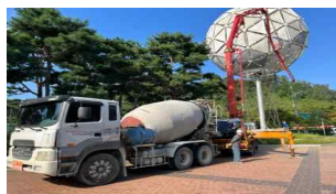
〈월드볼 보수 보강〉
