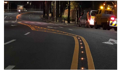
〈도로표지병 보완 시공〉
