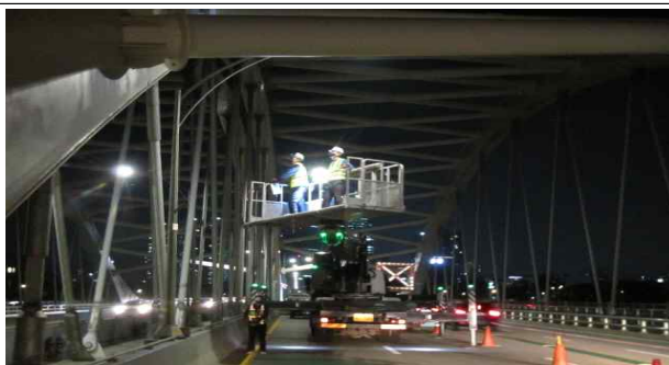
진단 및 점검 용역 전경
