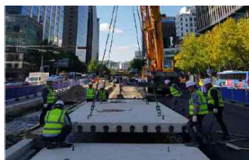
〈현장 조립 시공〉
