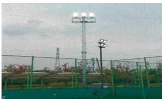
<족구장 조명시설 개선>
