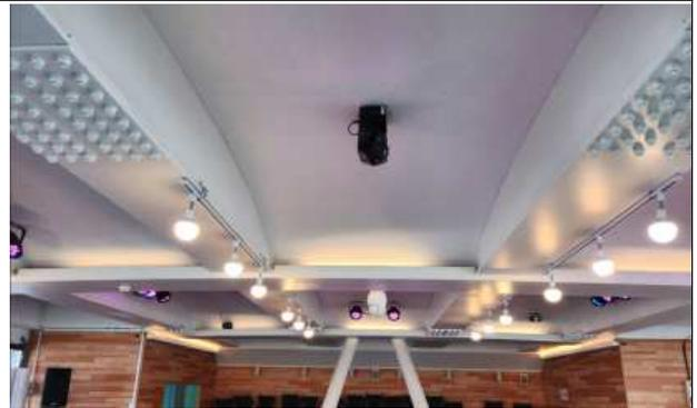
◆ 천공형 천장(적정온도 유지 어려움, 소음·분진 발생)을 단열, 차음이 가능하도록 리모델링, 조명등 설치
