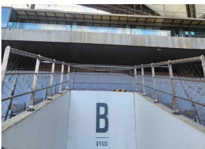
〈난간 안전그물망 설치〉
