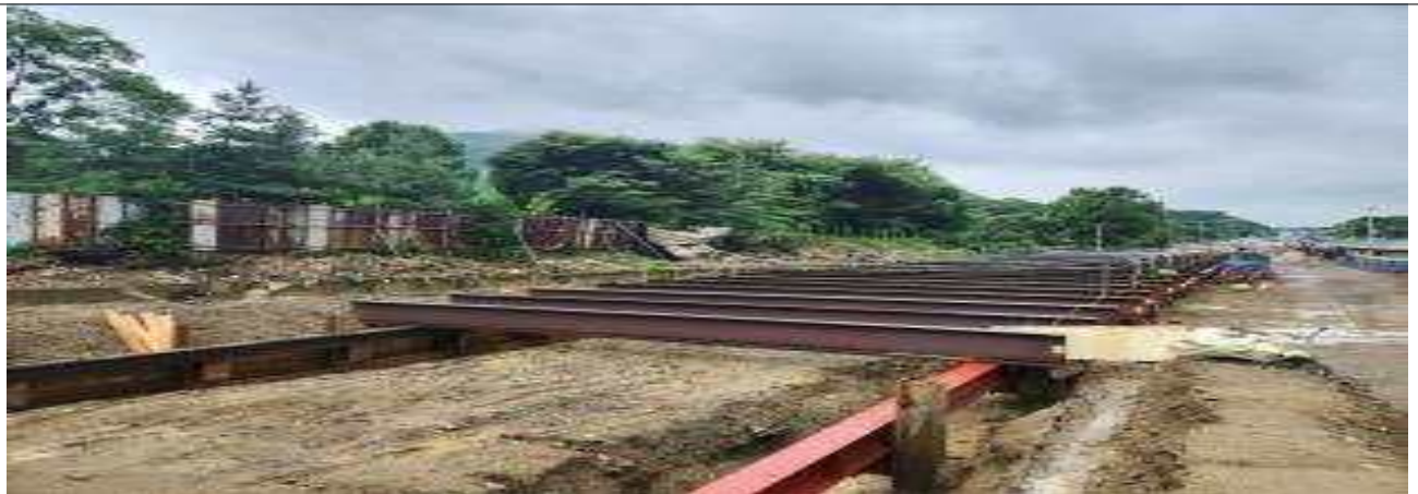
대모지하차도 복공 설치
