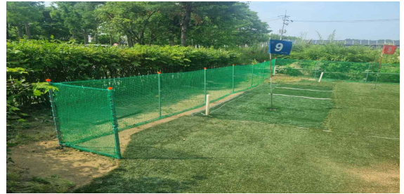
[(서남파크골프장) 안전망 설치('24.5월)]
