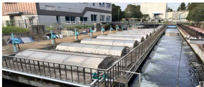
<탄천1처리장 여과시설 개선>
