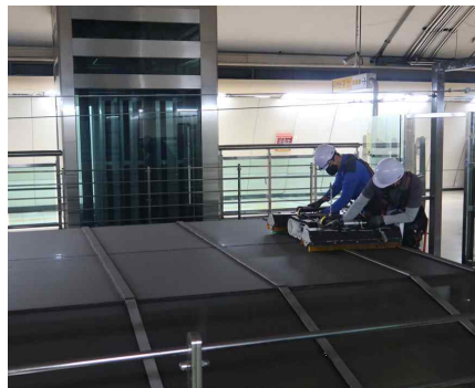
로봇 청소기를 이용한 승강장 유리지붕 청소
