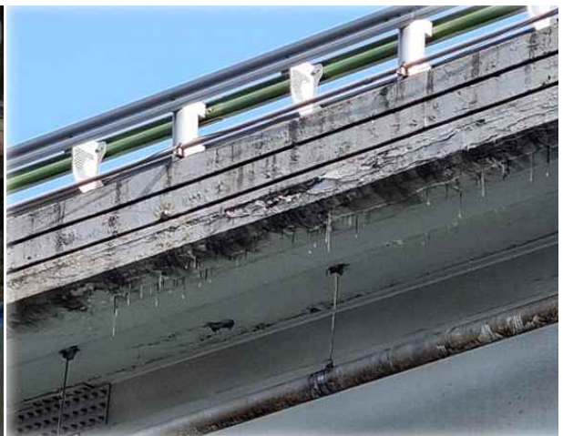
[공사 범위(연석, 캔틸레버) 현황]
