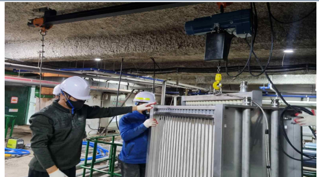
멤브레인 인양 작업
