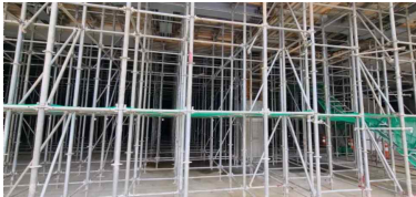
거푸집 동바리 설치
