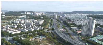
목동IC 연결램프 설치
