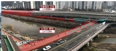
동부간선도로 노원교 램프 설치
