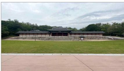
<궁궐 전면부 바닥정비 및 잔디 포장>
