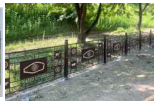
[북성벽 디자인펜스 설치]
