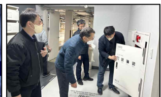
<정기 시설 안전 점검>
