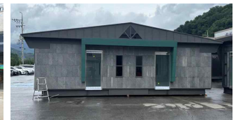
〈차고지 편의시설 개선〉
