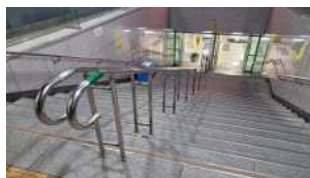
〈출입계단 중간난간 설치〉
