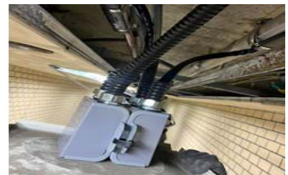
<동파방지용 메탈히터 설치>
