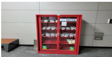
< 응급구조함 추가 설치 >
