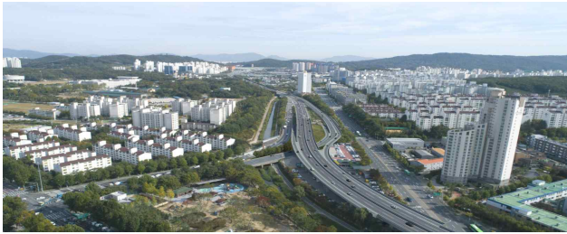
묵동IC 연결램프 설치
