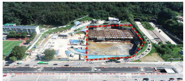
지하 굴토 및 구조물 공사 중(2022.09.현재)
