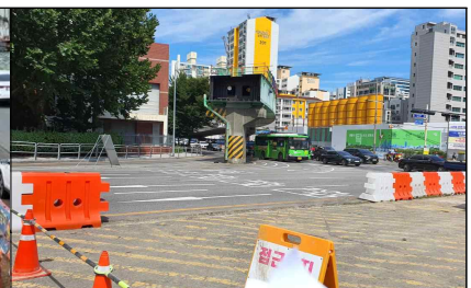
2단계 2공구 현황
