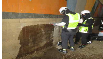
〈콘크리트 반발경도 비파괴시험〉
