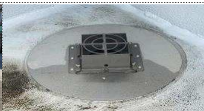
옥상 배수홈통 설치(과학기술회관)
