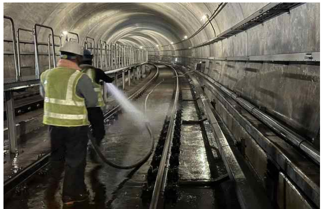
물청소 작업 중
